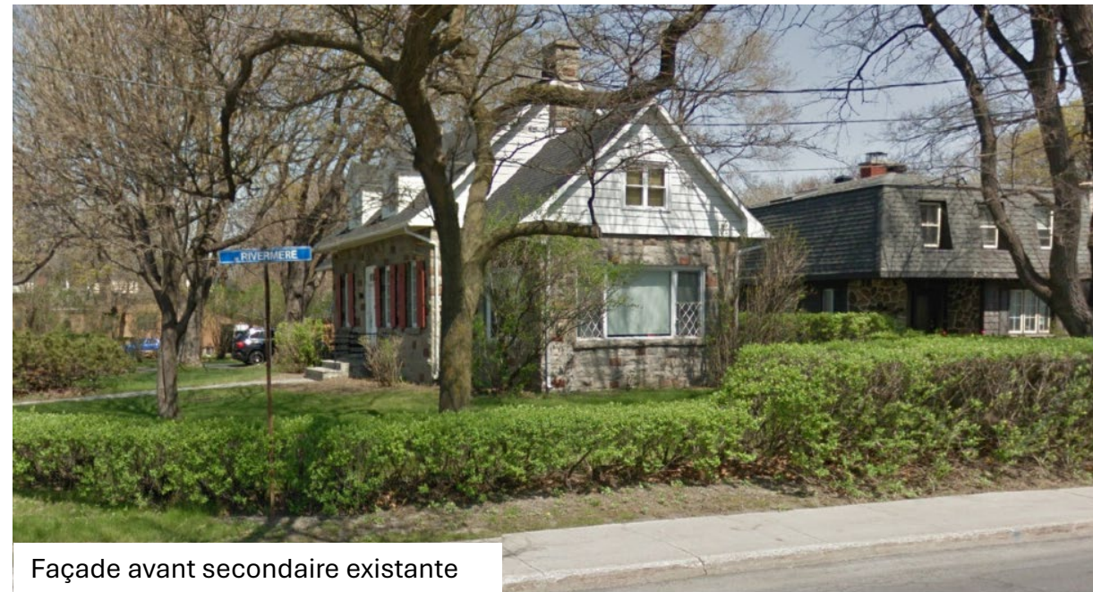
Façade avant existante
